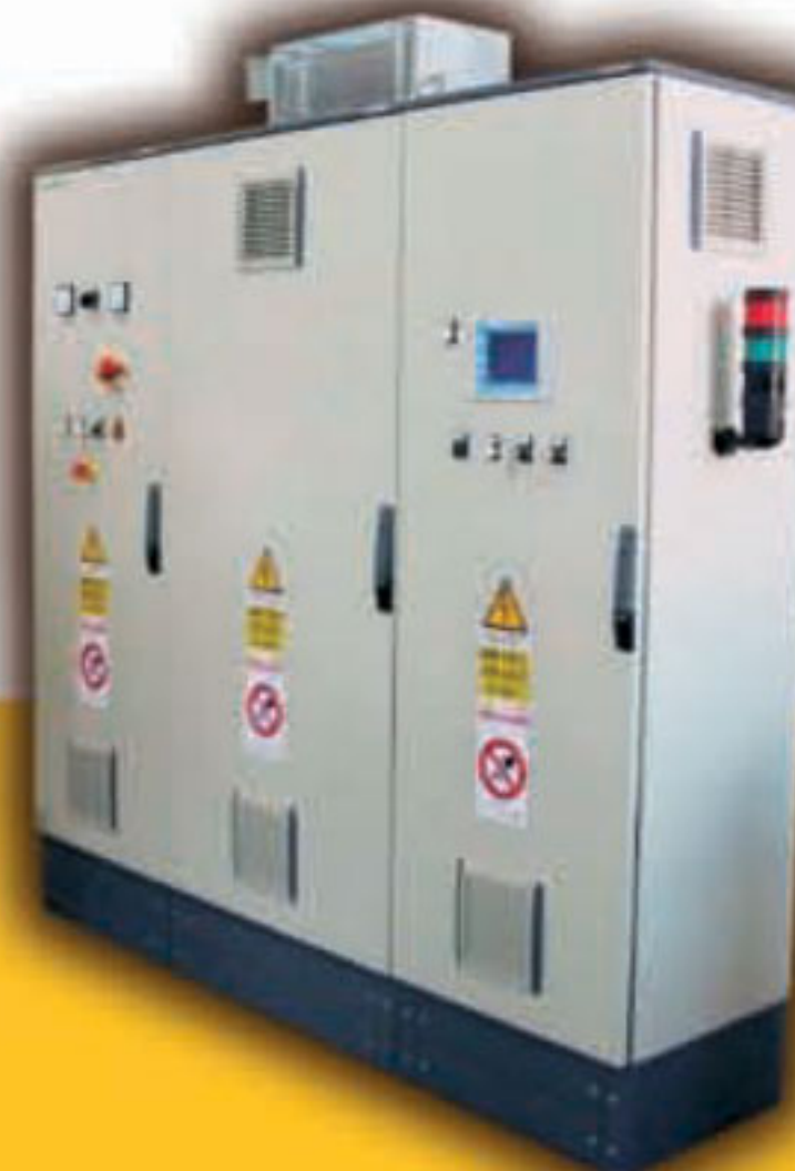
Quadro elettrico di automazione per comando linea di produzione. Controllo da terminale operatore touch-screen.
